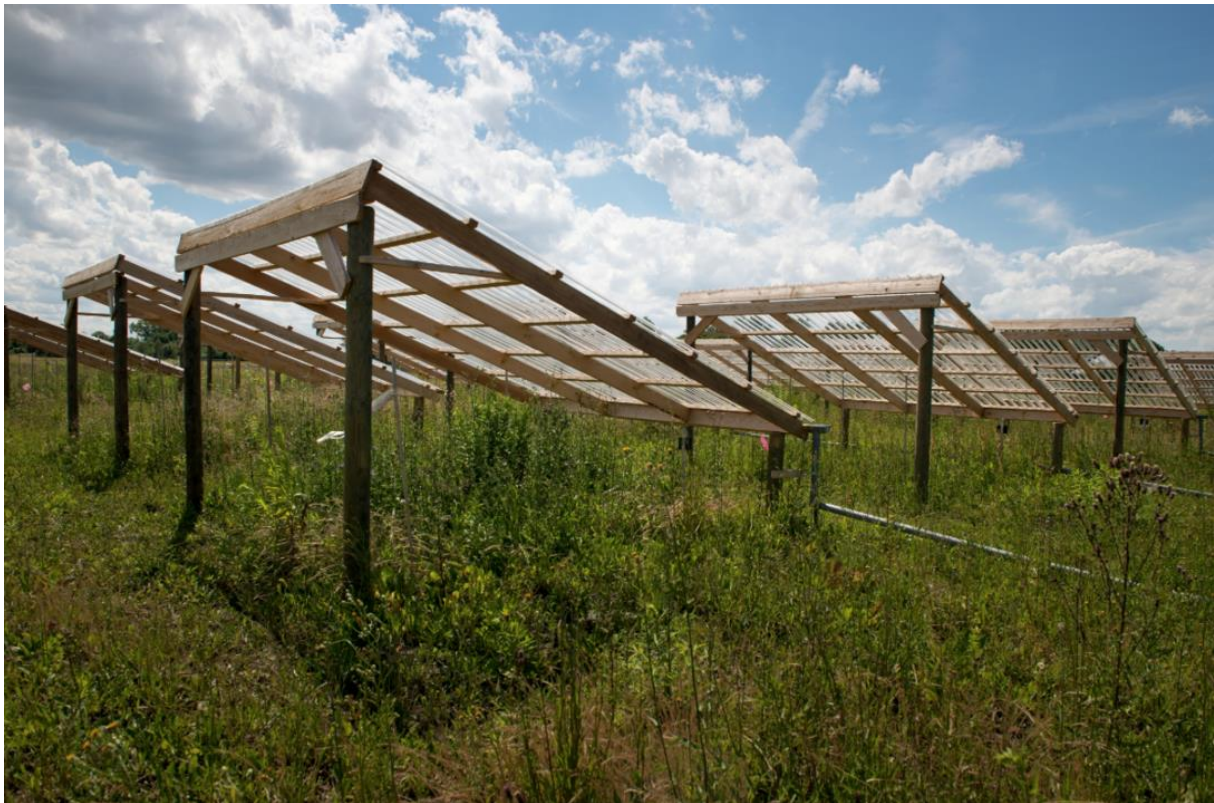
Abb. 1: Aufnahme der Dachkonstruktionen die Wasser von den Versuchspartzen ableiten und dadurch den Niederschlag um 55% reduzieren.
